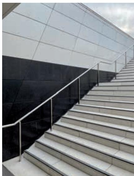
*Der Treppenaufgang des U-Bahnhofs Rotes Rathaus ist, ebenso wie die parallelogrammförmigen Fassadenplatten, aus edlem Betonwerkstein.*
