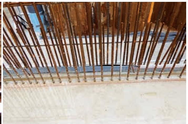
Bild 5 Wechsel des Fugenbleches
