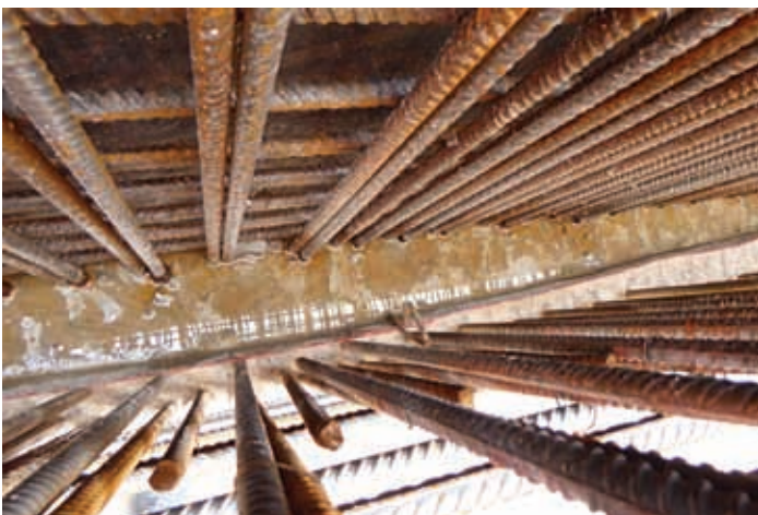
Bild 4 Einbauvariante des Fugenbleches
