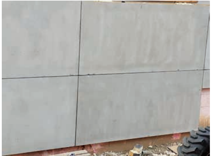
Bild 2b Montierte Fassadenelemente
