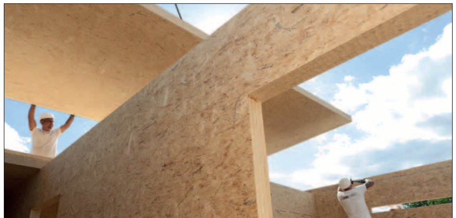
Elemente für Innen- wie Außenwände und Decken aus SWISS KRONO MAGNUMBOARD® OSB. (Bildnachweis: © SWISS KRONO / Foto: A. Kroth)
