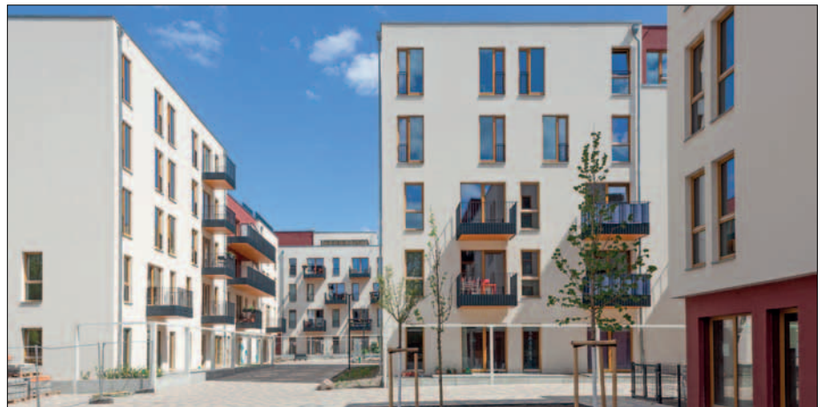
Das Wohnviertel Quartier WIR in Berlin Weißensee. (Bildnachweis: © SWISS KRONO / Deimel Oelschläger Architekten GmbH / Terhalle Holzbau GmbH / Foto: A. Kroth)
