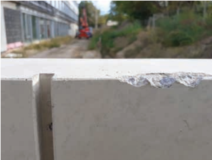
Bild 2a Fassadenelement nach Anlieferung
