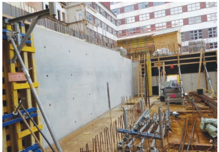
Bild 1 Sichtbetonwand nach dem Ausschalen
