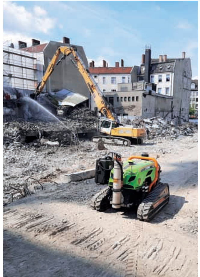
Sondierung per INN-Technik: Oberflächeneinsatz mittels eines ferngesteuerten Messträgers
