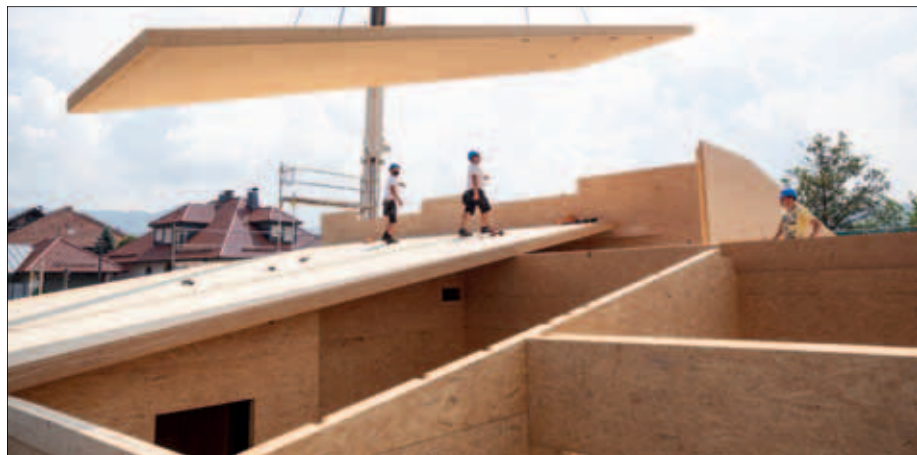
Wände und Decken aus großformatigen SWISS KRONO MAGNUMBOARD® OSB-Elementen werden schnell montiert (Bildnachweis: © SWISS KRONO Foto: tm studios)
