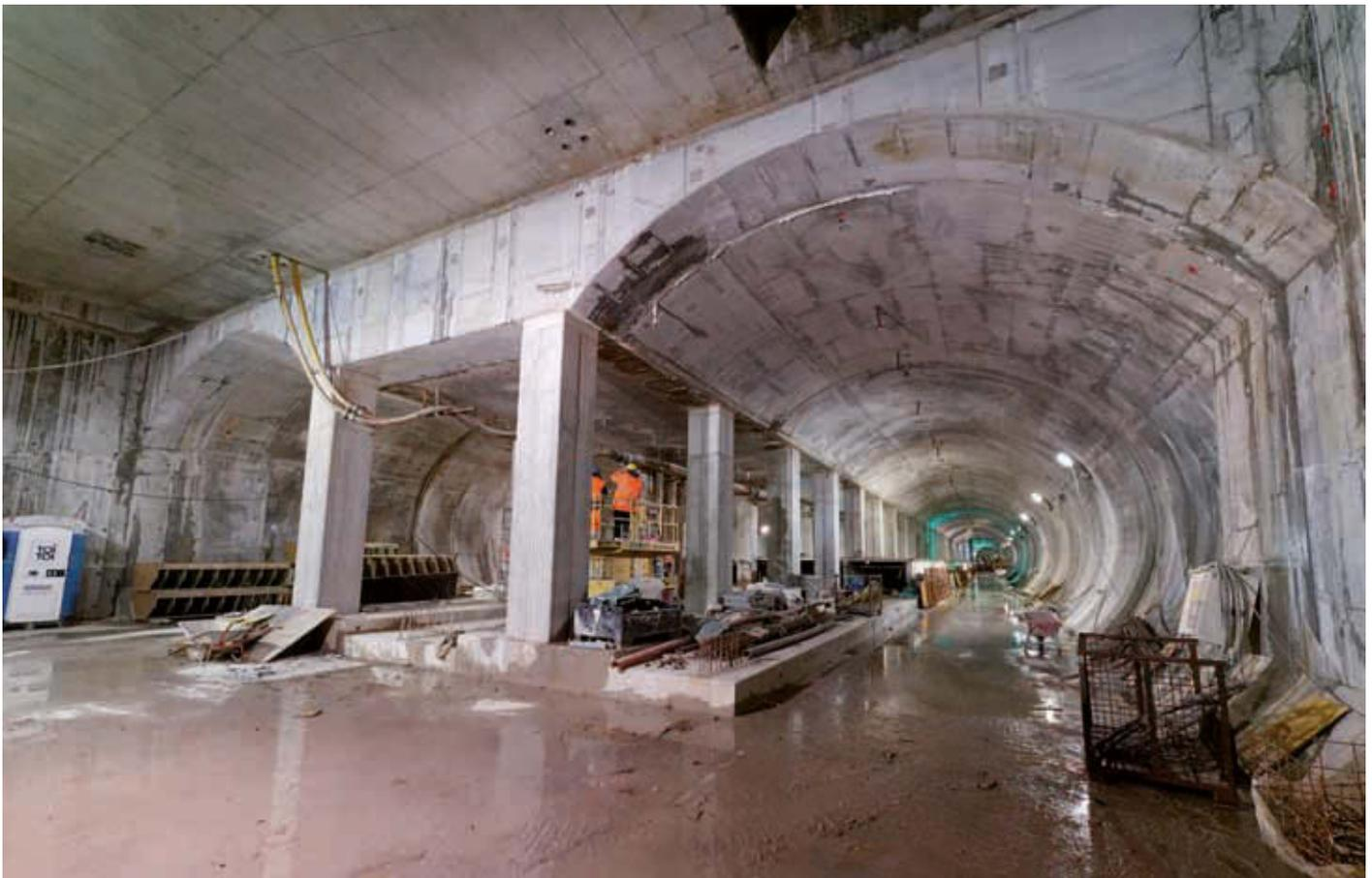
*Abb. 11: Die dreizellige Bahnsteighalle vor Einbau der Bahnsteigplatte.*
