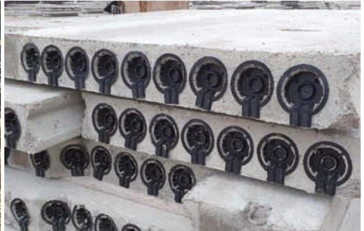
Bild 2 Beispiel einer Hohlkammerdecke als Vollfertigteil
