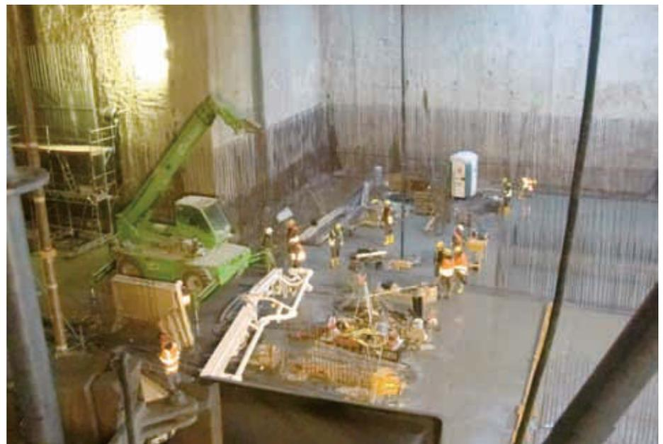
**Sohlbetonage des zweistöckigen U-Bahnhofs in 16 Metern Tiefe.** Foto: M. Kopsch
