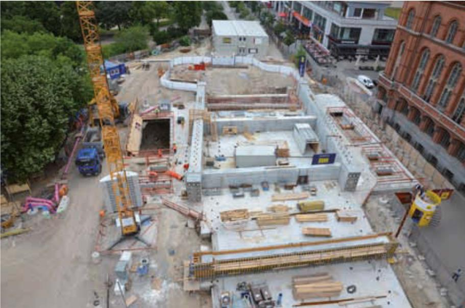
**Stahlüberzüge halten die Decke und gewähren Baufreiheit untertage.** Foto: M. Kopsch
