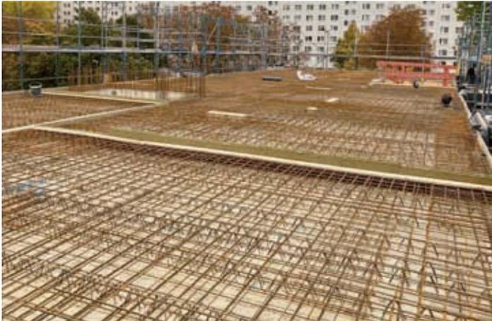
Bild 1 Beispiel einer Elementdecke als Halbfertigteil
