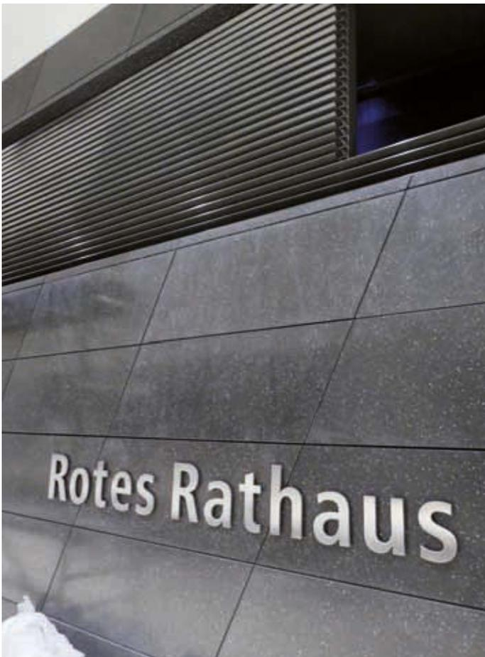
Die Wände wurden aufwändig mit Betonwerksteinplatten verkleidet.
