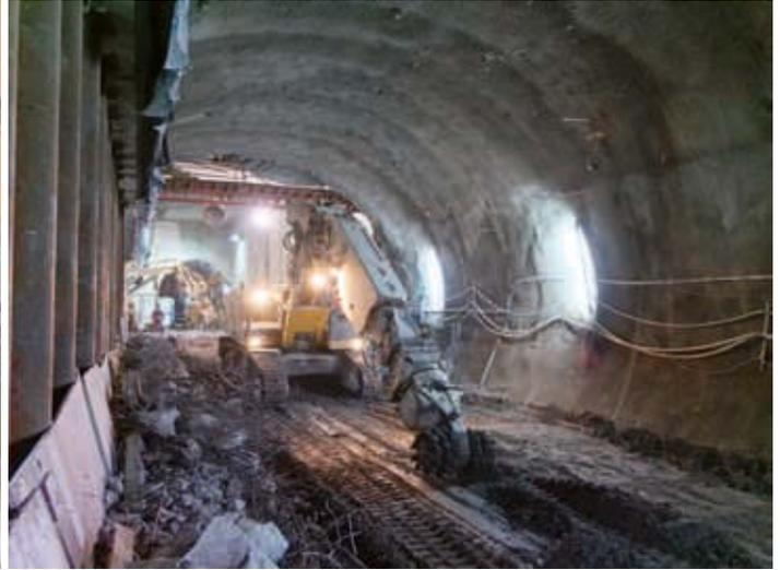
*Abbruch und Aufweitung der vereisten Tübbingtunnel. Erst fräsen, dann Spritzbeton.*
