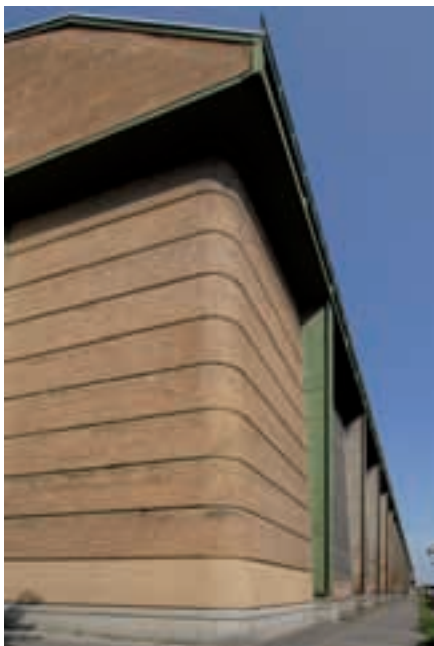
AEG-Turbinenhalle (1908/09): Der wohl bekannteste Industriebau Karl Bernhards
