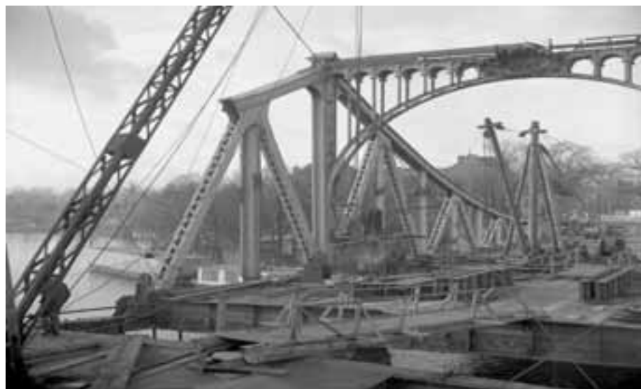
Glienicker Brücke (1905– 1908, 1947–49): Wiederaufbau 1948
