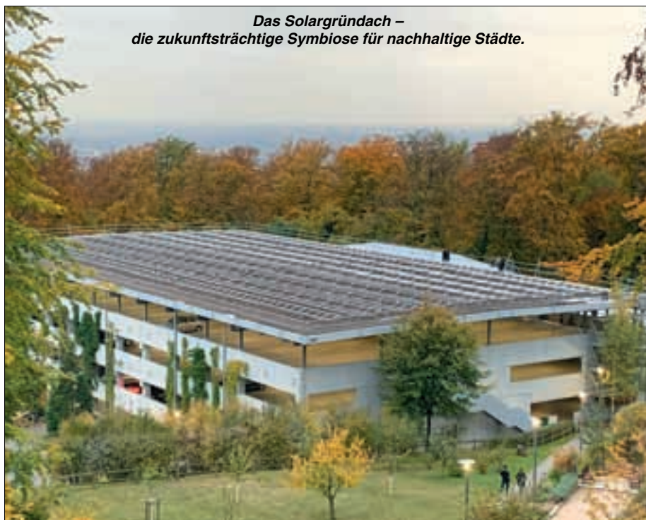
Die neue Solaraufständering OPTIGRÜN-SOLAR FKD auf dem EMBL-Parkhaus in Heidelberg.
