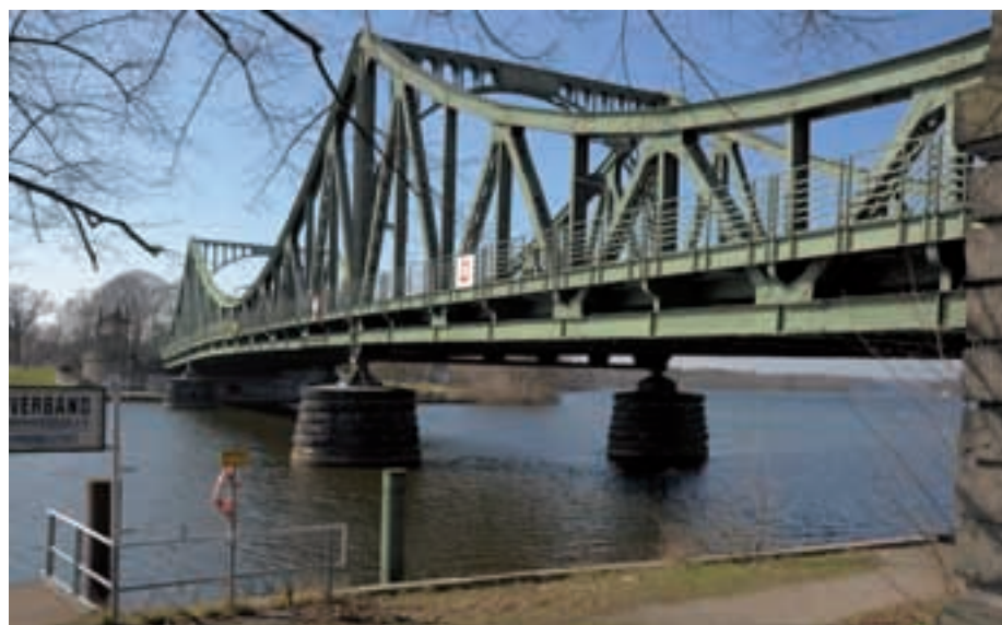
Glienicker Brücke: Kunstvoll repariert
