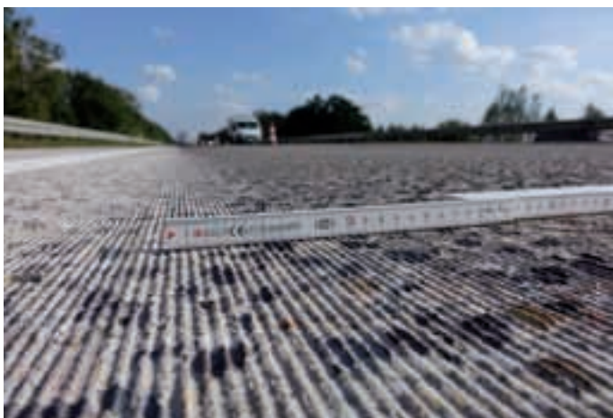
Abbildung 1: Betonfahrbahnoberfläche mit Grindingtextur auf der BAB A10 bei Berlin
