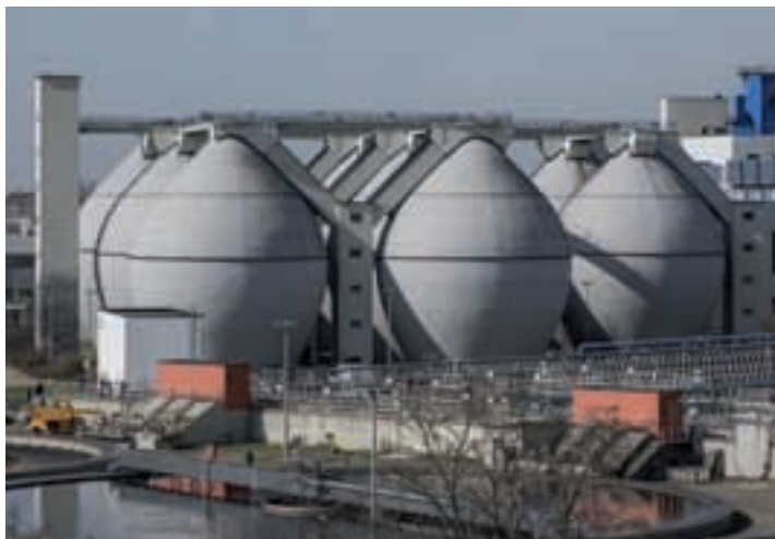
Faultürme des Klärwerks Ruhleben (1957–59): Spannbetonschalen in Segmentbauweise
