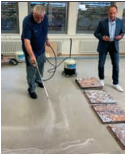
Mit UZIN U 5000 bringt Uzin als erster Hersteller der Branche eine weichmacherbeständige Fixierung auf den Markt, die im Sprühverfahren aufgetragen wird.
