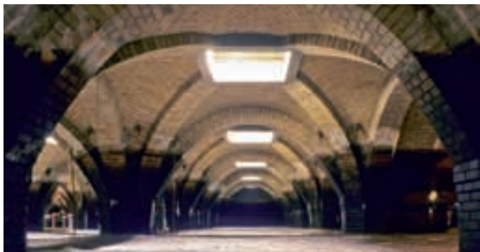
Wasserwerk Friedrichshagen (1889–99): Kreuzgewölbe der Sandfilterhallen
