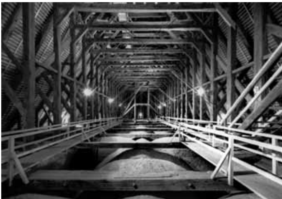
Dachwerk der Spandauer Nikolaikirche (um 1370): Ingenieurbaukunst des Mittelalters
