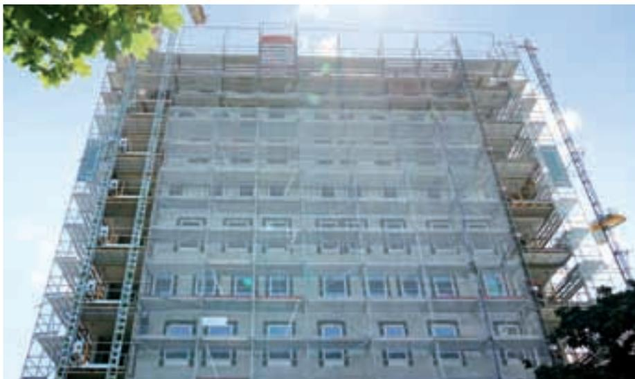
*Bild oben und unten: Bauaufzug mit Zugang zu den Geschossen*
