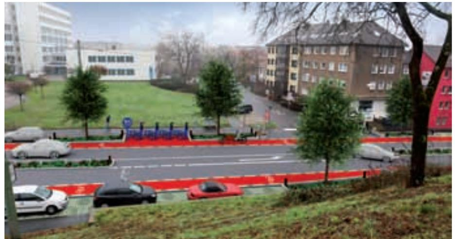
Niederschlagswasser dezentral behandelt und versickert. Der Drosselabfluss des Systems aus 35 Baum-Rigolen, 126 Tiefbeet-Rigolen und gedichteten Füllkörperrigolen in den zwei Kreuzungsbereichen wird gedrosselt über einen neu geplanten RW-Kanal abgeleitet. Das modifizierte Mischsystem ist auf die Anforderungen des hochversiegelten Straßenraums sowohl für den Bemessungs- als auch den Überflutungsfall angepasst.
