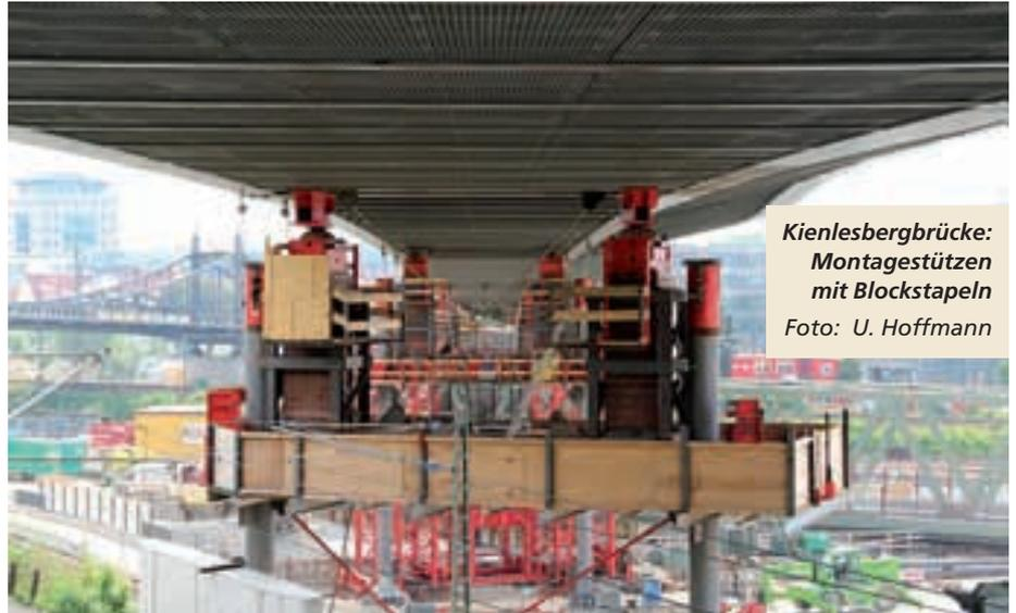
**Kienlesbergbrücke: Montaggestützen mit Blockstapeln**
