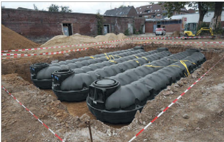
Baugrube mit Böschung. Als einfachere und kostengünstigere Alternative dazu hat Premier Tech großvolumige PE-Flachtanks entwickelt. Die NEOplus-Behälter fassen bis zu 50.000 Liter und benötigen dank ihrer geringen Höhe von 1,4 m nur eine flache Baugrube ohne Böschung. Durch ihre spezielle Geome-
