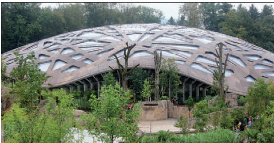
Starke Platten für das Elefantenhaus im Züricher Zoo: 4.000 m<sup>2</sup> esb-Platten wurden in der imposanten Dachkonstruktion verbaut.
