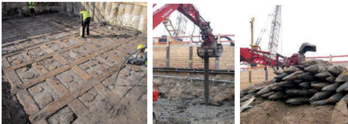
Abb. 14 Rückbau der bestehenden Holzpfahlgründung
