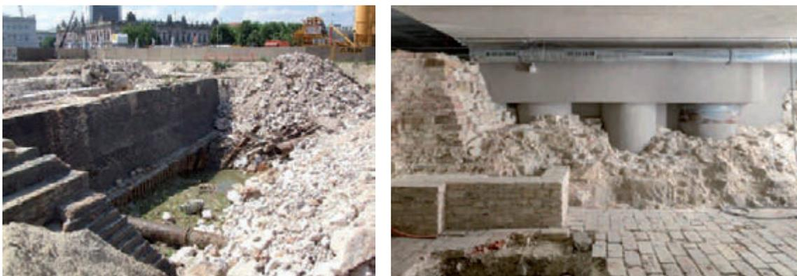
Abb. 16 Reste des Bestandsmauerwerks vor und nach dem Einbringen der Tiefgründung
