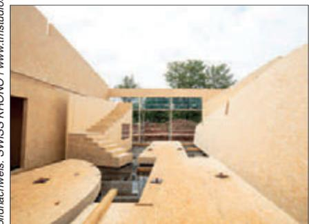
Montage der vorgefertigten Wand- und Deckenelementen aus SWISS KRONO MAGNUM-BOARD® OSB.
