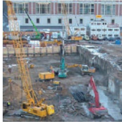
Abb. 12 Trogbaugrube
