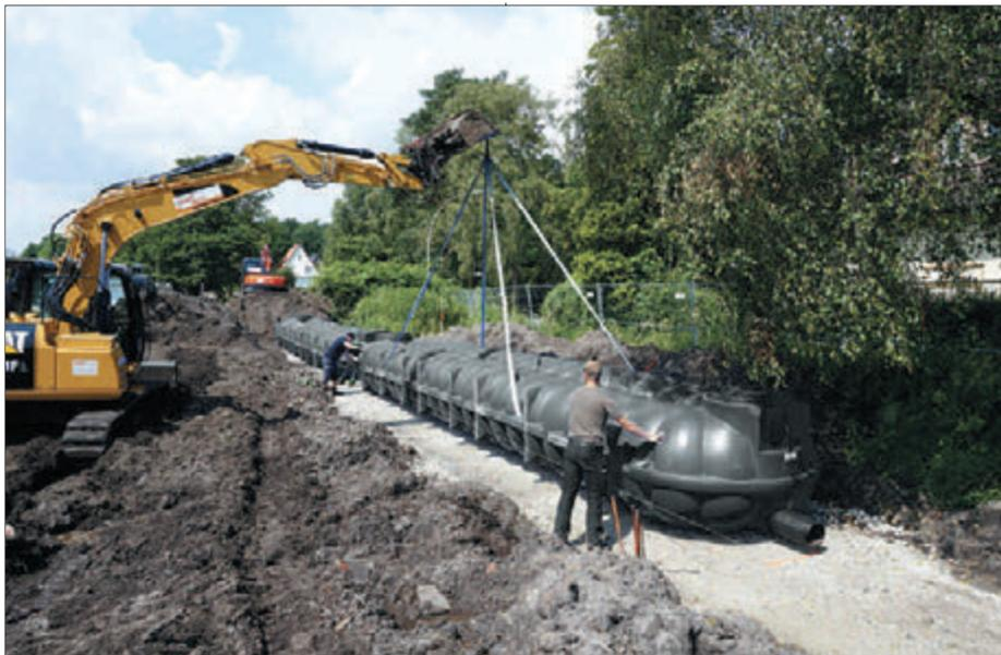
**Einbaubeispiele NEOplus:** Mit den großvolumigen Flachtanks reduziert sich der Bauaufwand erheblich. Sie lassen sich einfach mit einem Aushubbagger transportieren und benötigen eine wesentlich flachere Baugrube als herkömmliche Tanks.
