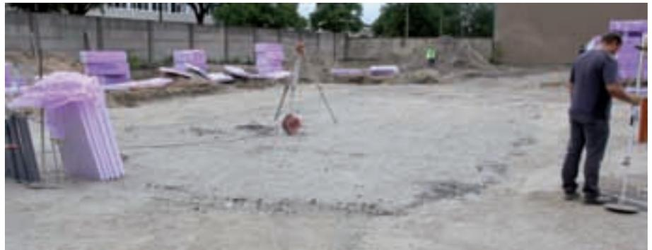
**Bild 10: Feinplanum für Aufbringung der Bodenplattendämmung**
