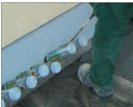
Betroffen sind meist ältere Gebäude, bei denen die Horizontalsperre gegen die aufsteigende Feuchtigkeit im Boden fehlt oder schadhaft ist.
