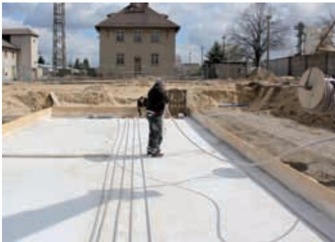
**Bild 4:** Legung der Wellrohre
