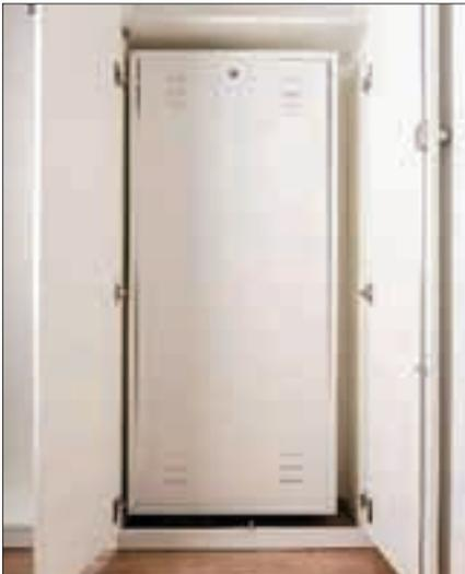
**Pro Einheit übernimmt eine AEG Wohnungsstation effizient die bedarfsgerechte Wärmeversorgung und hygienische Trinkwassererwärmung. Unterhalb der Wohnungsstation befindet sich der Heizkreisverteiler. Die gesamte Technik verbirgt sich in einem Verteilerschrank, der wiederum im Wandschrank der Garderobe platziert ist.**
