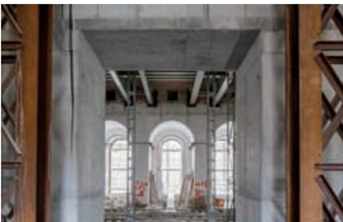
**Im Nordflügel wurde eine neue tragende Wand errichtet: Durchbrüche auf der Hauptausstellungsebene eröffnen neue Perspektiven.**
