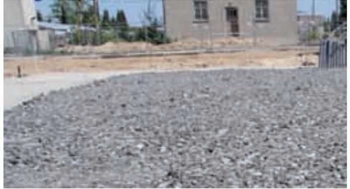
**Bild 9: Glasschaumschotter aufgebracht und verdichtet**
