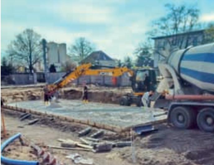
**Bild 2:** Einbau des pumpfähigen Makadamgemischs
