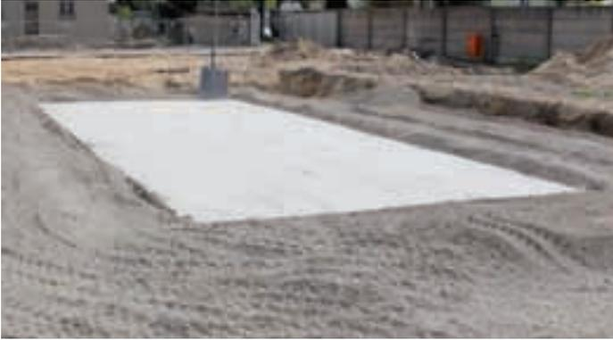
**Bild 8: Fertiggestellter Makadamspeicher mit seitlicher Anfüllung der Baugrube mit RC-Material**
