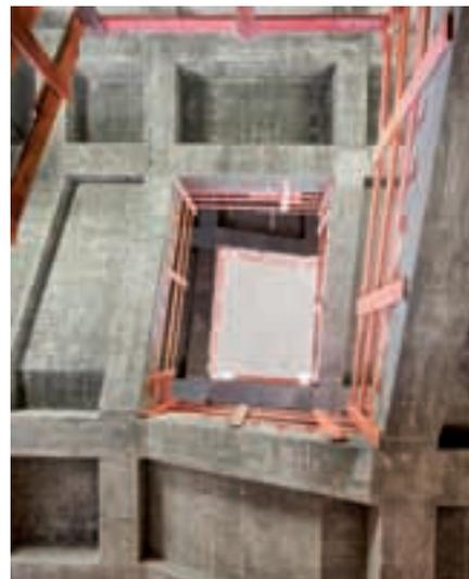
*Zwischen dem Nordflügel und dem Nordflügel-Kopfbau des Pergamonmuseums wurde innerhalb des Bestandsgebäudes ein komplett neues Treppenhaus gebaut.*
