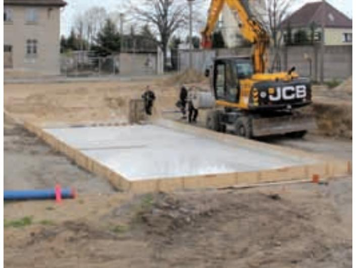
**Bild 3:** Erste Randschalung und seitliche RC-Materialanschüttung
