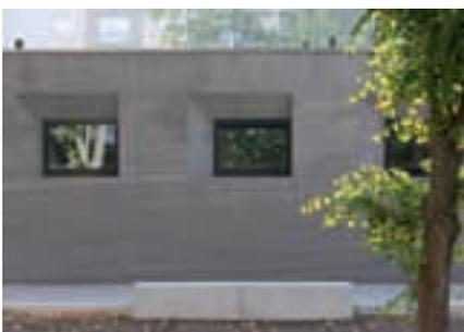
**03 Wände ohne Wärmedämmung – und mit ganz eigener Ästhetik. Da Infralichtbeton nicht gepumpt, sondern geschüttet wird, zeichnen sich die Lagen in der Fassade ab, wie in einem Steinbruch.**
