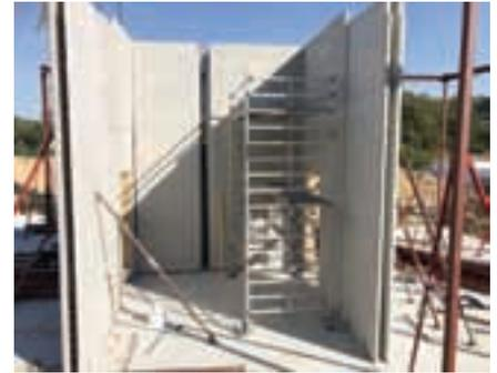
**Das Treppenhaus ist der stabilisierend Kern der Stahlkonstruktion. Zusammen mit den Geschossdecken ergibt sich ein Speichervolumen von 133 m<sup>3</sup>.**
