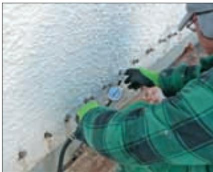
Die Silikonharzlösung wird über Bohrkanäle in die Mauer injiziert und bildet dort eine unverrottbare Sperre.
